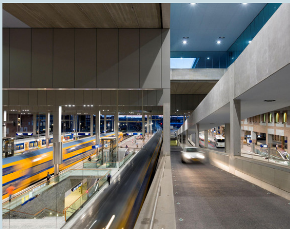
parkeren bovenop stationsgebouw - Breda, NL
